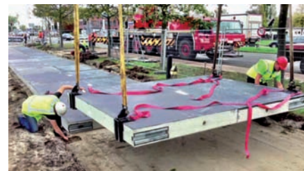
Operarios instalan un módulo prefabricado de pavimento SolaRoad en Holanda.
