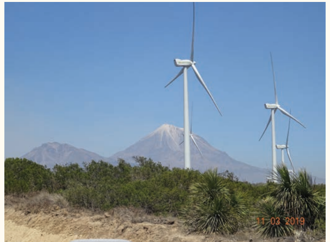
Figura 2. Parque Eólico de 220 MW ubicada en el estado de Puebla. 220 MW wind farm located in the state of Puebla.
