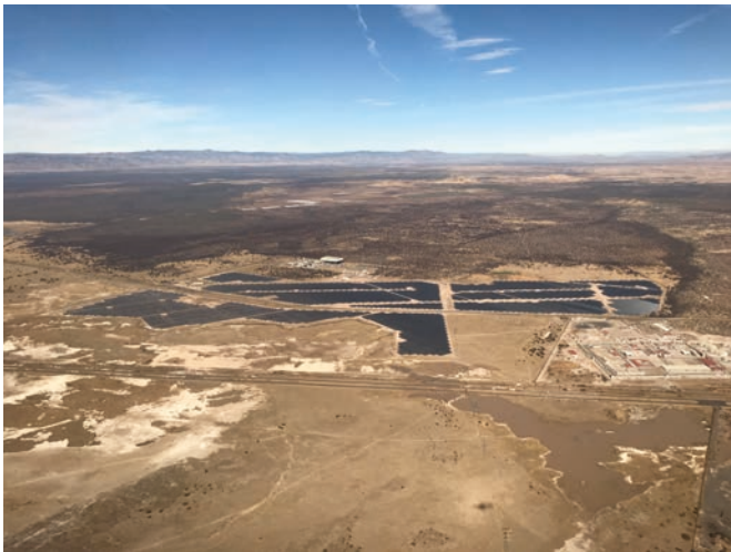
Figura 1. Planta Solar de 90 MW ubicada en el estado de Durango. 90 MW Solar Plant located in the state of Durango.
