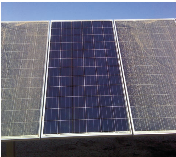
Figura 1. Ensuciamiento de módulos fotovoltaicos en campo. / Figure 1. Soiling of photovoltaic modules in the field.
