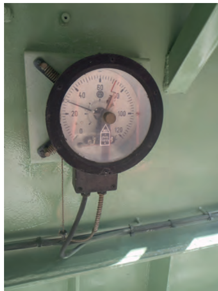
Termómetro analógico para medida de temperatura en arrollamientos
