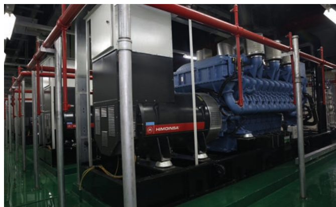
Proyecto de 24 MW en el Data Center del grupo Alibaba en China.
