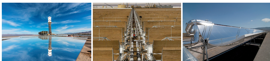
De izquierda a derecha, Ivanpah, la planta de tres torres y 392 MW de capacidad, comenzó operación comercial en febrero de 2014. Imagen cortesía de BrightSource Energy. Mojave, en California, también comenzó operación comercial en 2014. Imagen cortesía de Abengoa. Instalación con tecnología cilindroparabólica. CIEMAT.
