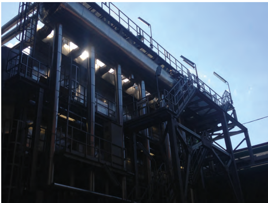
Caldera de recuperación de calor instalada en Ori Martin. Fuente: ORI MARTIN
