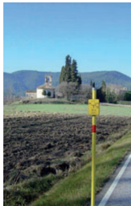
Hito de señalización. Foto cedida por Gas Natural Fenosa.
