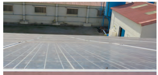
Imagen 5: Suciedad arenosa en módulos fotovoltaicos (Fuente: Photovalía Solar Services).
