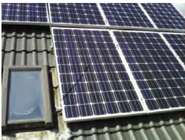
Imagen 4: Efecto de zona caliente provocado por pequeño sombreado. (Fuente: M. Diehl).
