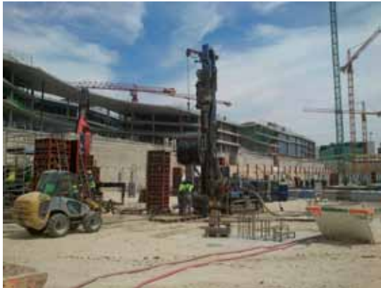
Replanteo de perforaciones y zona de actuación de equipos.
