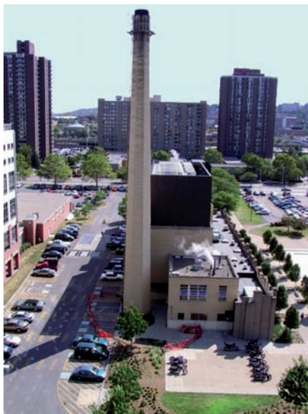
Ilustración 1: Central Térmica de EEUU, Siracusa, NY http://www.ongov.net/
