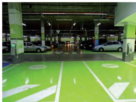
Parking en centro comercial con zona para vehículos eléctricos.
