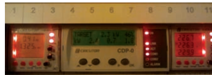
Arriba: vista parcial de campo solar del proyecto RECARGO. Debajo: detalle del modulador de potencia CDP0 que realiza el control con inyección cero.
