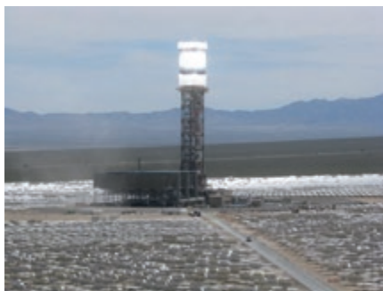
Ivanpah (California EEUU) será la mayor planta de torre del mundo con 392 MW.
