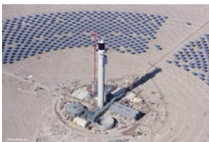
Planta de Crescent Dunes (Nevada, EEUU).
