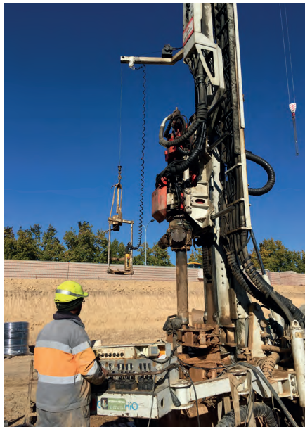
Trabajos de perforación en el Centro Integral de Servicios Ibermutuamur, Valladolid (cortesía de Geotermia Vertical).
