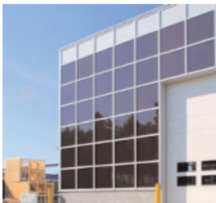
PV Glass: la fachada de un edificio realizada como muro cortina con el módulo translúcido de silicio amorfo PV Glass de MSK.
