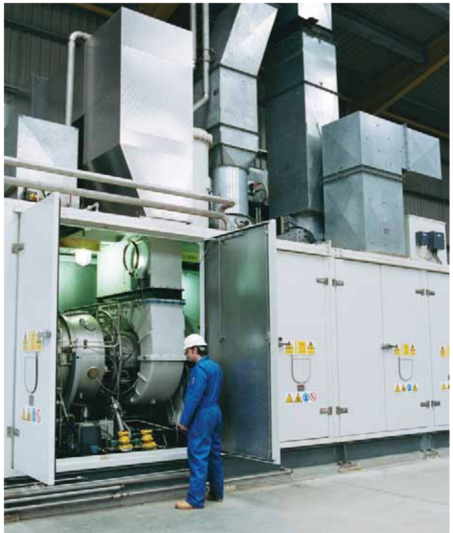
Un paquete de cogeneración de turbinas de gas industriales de 5,25 MW(e), que incluye una turbina de gas SGT-100 de Siemens, un generador y equipos auxiliares, y que proporciona calor y electricidad.
