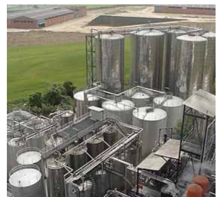
Lípidos Santiga. La planta de CHP (cogeneración), que depende de la turbina de gas de Siemens SGT-100 5,25 MW, aumenta el vapor y genera la potencia eléctrica para cubrir la necesidad de una planta procesadora de lubricante y grasas cerca de Barcelona.
