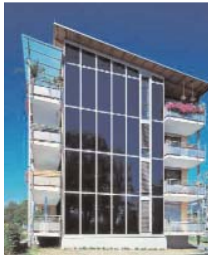
Fachada de integración fotovoltaica-Schüco.
