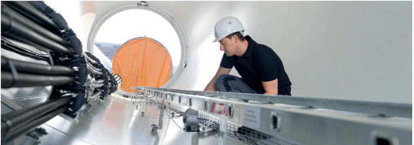
han conectado 200 metros con cable de 2,5 mm<sup>2</sup> de sección. Todo está listo para alimentar una tensión de 120 V en corriente continua y distribuirla a lo largo de 120 metros hasta la góndola.
